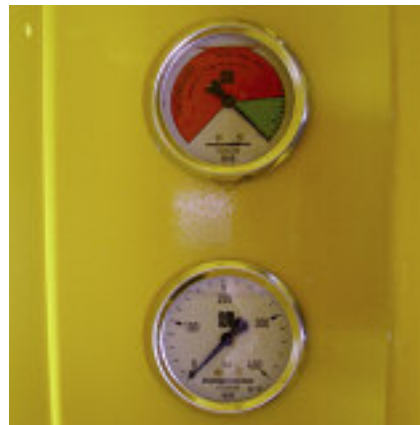
Ein Blick und die Sache ist klar: Wie stark die Saugfilter verschmutzt sind, erkennt man sofort auf übersichtlichen Anzeigen im Schaltschrank.
