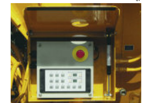
Die Bedieneinheit hinten rechts für den Ortbetrieb der Maschine und zur Anzeige von Pumpdaten
